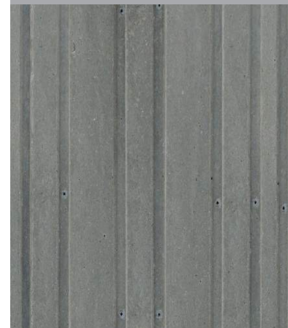
鋼板の脱型後
