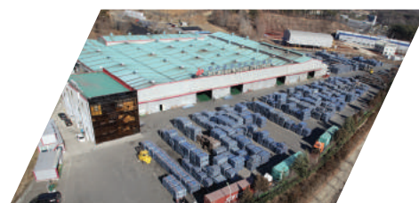
天安工場竣工
