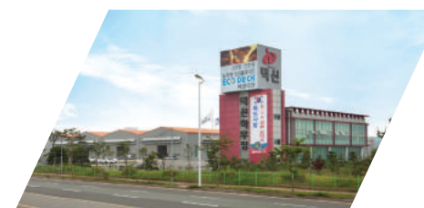
群山工場竣工
