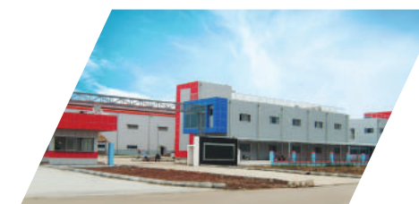
トクシンVINA生産工場 (ベトナムハイフォン)竣工
