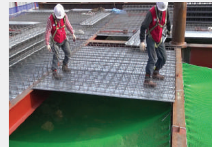
④ デッキ仮置
