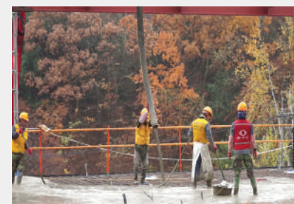
⑩ コンクリート打設
